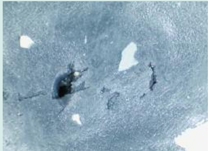
Zerstörter PUR-Werksfinish auf einem Elastomerbelag durch mechanische Belastung wie von spitzen Steinchen, zu sehen in 200-facher Vergrößerung.
