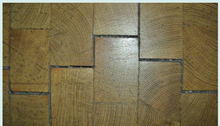
Spannungsriss im Holzpfaster durch fehlende Dehnungsfuge.
